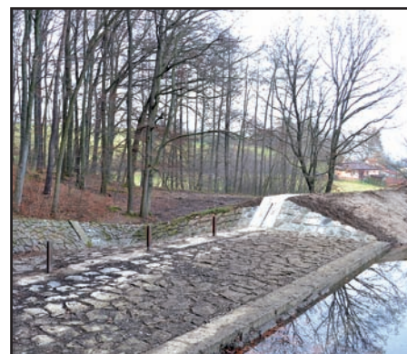
Listopad - Opravy přepadu retenční nádrže Lubná. Foto: J. Šáchová.
