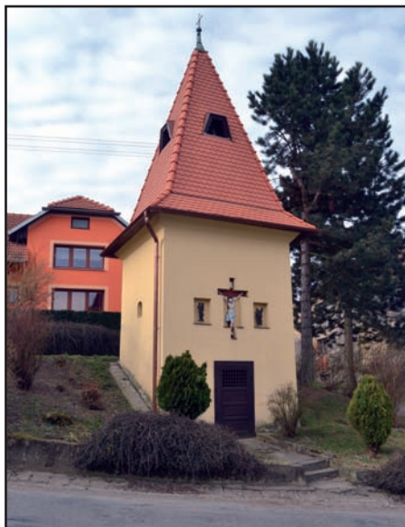
Nová střecha na obecní kapličce.
