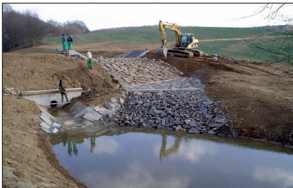
Výstavba poldru v r. 2011. V rámci realizace byly vytvořeny 2 samostatné tůňe a mokřad, provedena revitalizace vodního toku a vysazena doprovodná zeleň.
