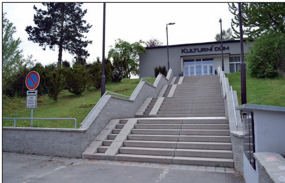
Oprava schodiště před kulturním domem v r. 2012.
